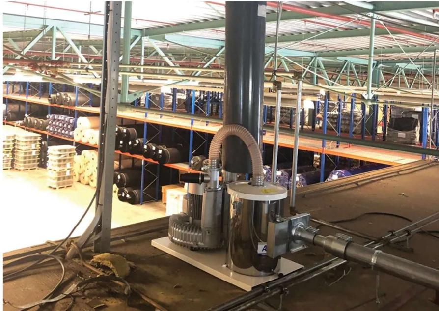
این جاروبرقی صنعتی مازولار یک مکنده صنعتی دائم کار ثابت در محیط های صنعتی محسوب می شود. این دستگاه توانایی مکش همزمان مایعات و جامدات را داشته و با ساختاری فشرده و تفکیک پذیر (مازولار) مناسب استفاده در محیط هایی با فضای محدود می باشد.
